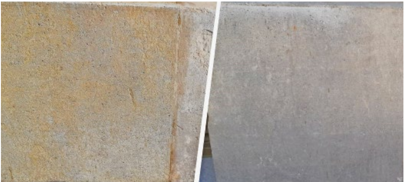
↑ Reinigung eines verunreinigten Sockels – links vorher, rechts nachher.
